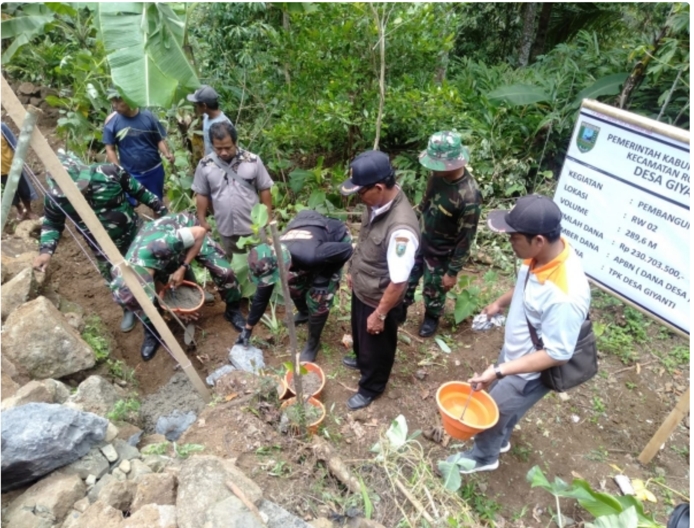
Peletakan batu pertama Pra TMMD Sengkuyung Tahap III di desa Giyanti kecamatan Rowokele, Kabupaten Kebumen, Provinsi Jawa Tengah
